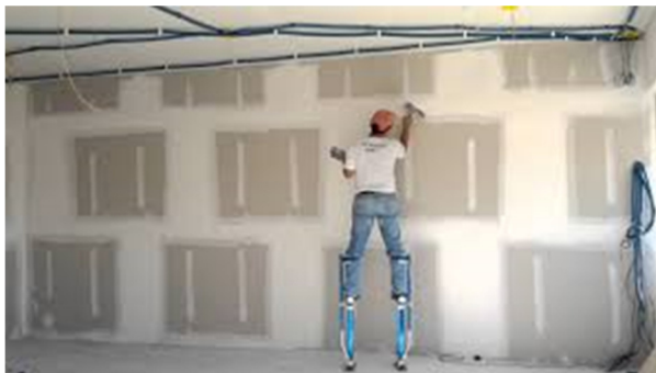
Figura 2 - Construção a seco
