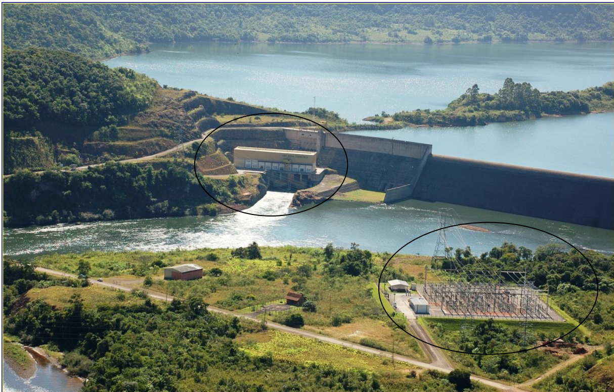
Figura 2- Usina Hidroelétrica Dona Francisca
