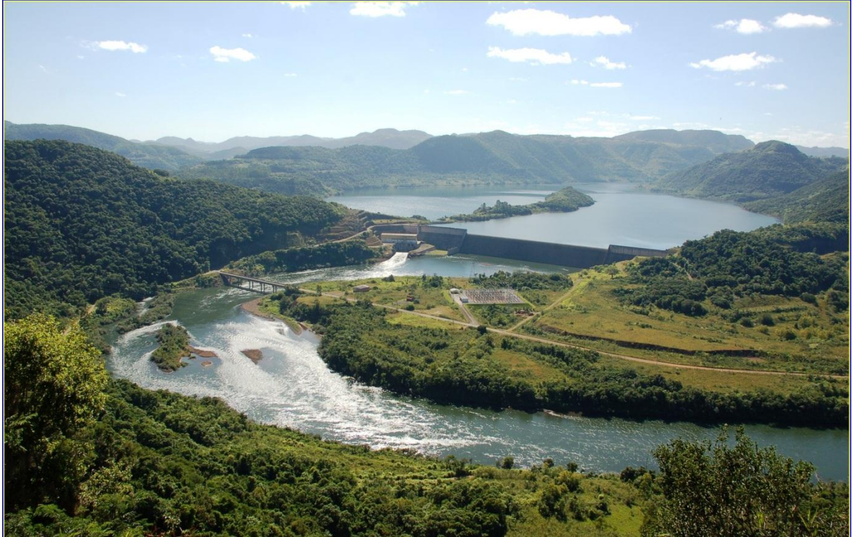
Figura 1- Usina Hidroelétrica Dona Francisca
