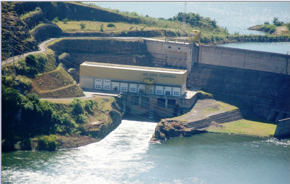
Figura 4- Sede da Dona Francisca Energética S/A. Território do Município de Nova Palma. Local da instalação das turbinas e dos geradores.
