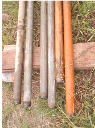
Foto: Acervo Recanto Maestro Loteamento – Tubulações danificadas removidas e substituídas 2003
