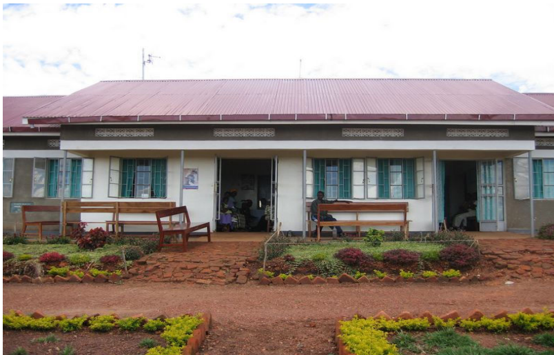
Figura 2: Centro de atendimento construído após o Projeto Vilas do Milênio ser implantado em Ruhira, Uganda Fonte: Galeria de imagens Millennium Promise
