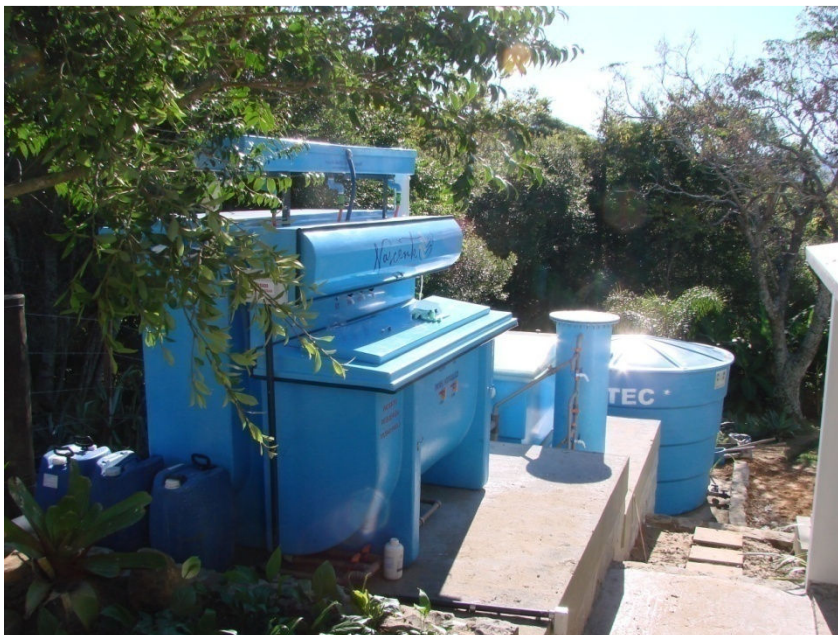
Figura 9: Foto da Estação de Tratamento de Efluente (ETE)
