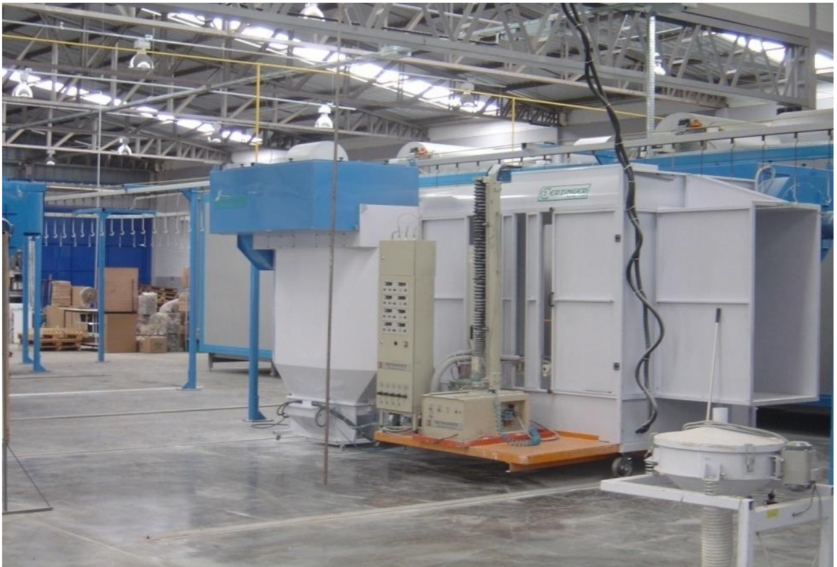
Figura 3 - Cabine de pintura
